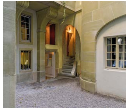
Aussenansicht des Restaurant «Romy» in der Laube Rathausgasse II und Ansicht vom Innenhof.
